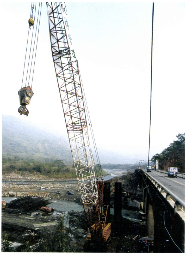
▲ 國姓橋為北港溪與南港溪的交會處，舊橋橋面窄小行車不便，現已重建施工中，完工後將有助烏溪沿岸旅遊觀光事業之發展。
