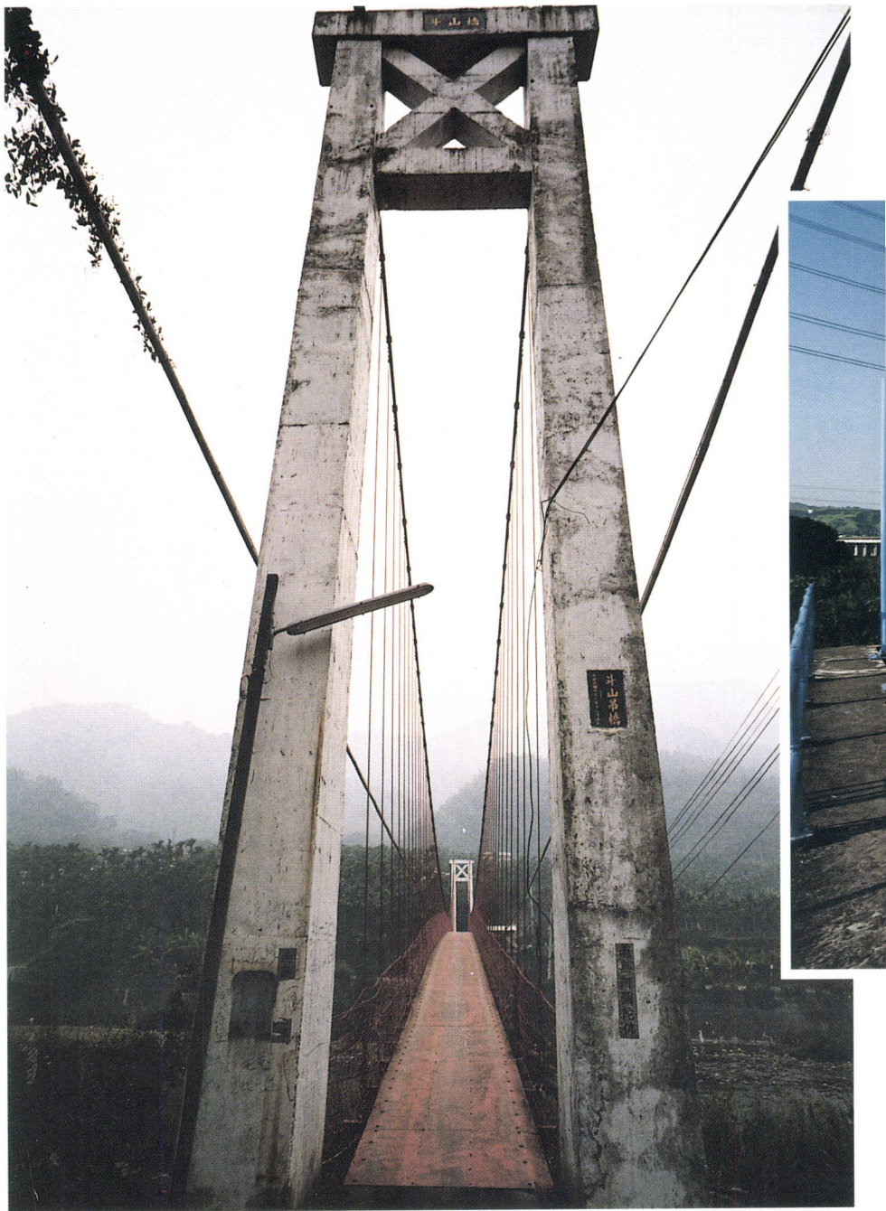
▲ 斗山吊橋座落國姓鄉大石村，全長一五五公尺橫跨南港溪上，橋上鋪設鋼板，車行其間鏗鏘作響，有不一樣的感覺。
