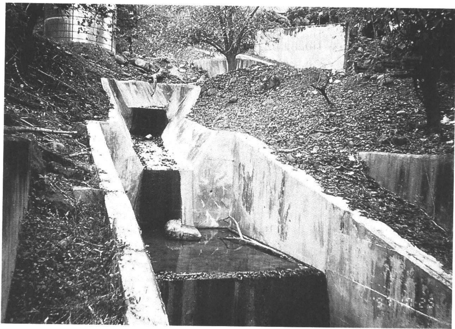
◆水庫上游水土保持——消能跌水工，可減緩流速，緩和泥砂之沖蝕進入水庫。（成功大學水利系提供）
