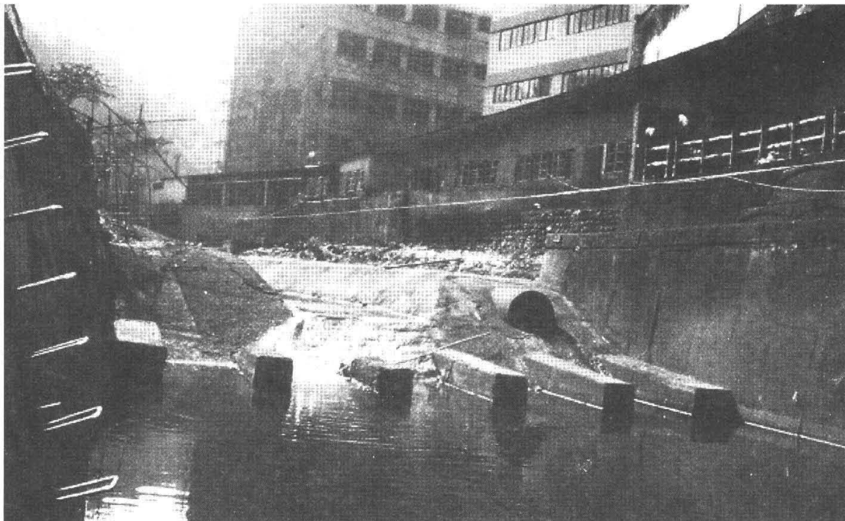
圖6：上、中華工專河段河道皆為混凝土所覆蓋，本段為靜水池之水工設施，河岸景觀單調，毫無綠意可言。
