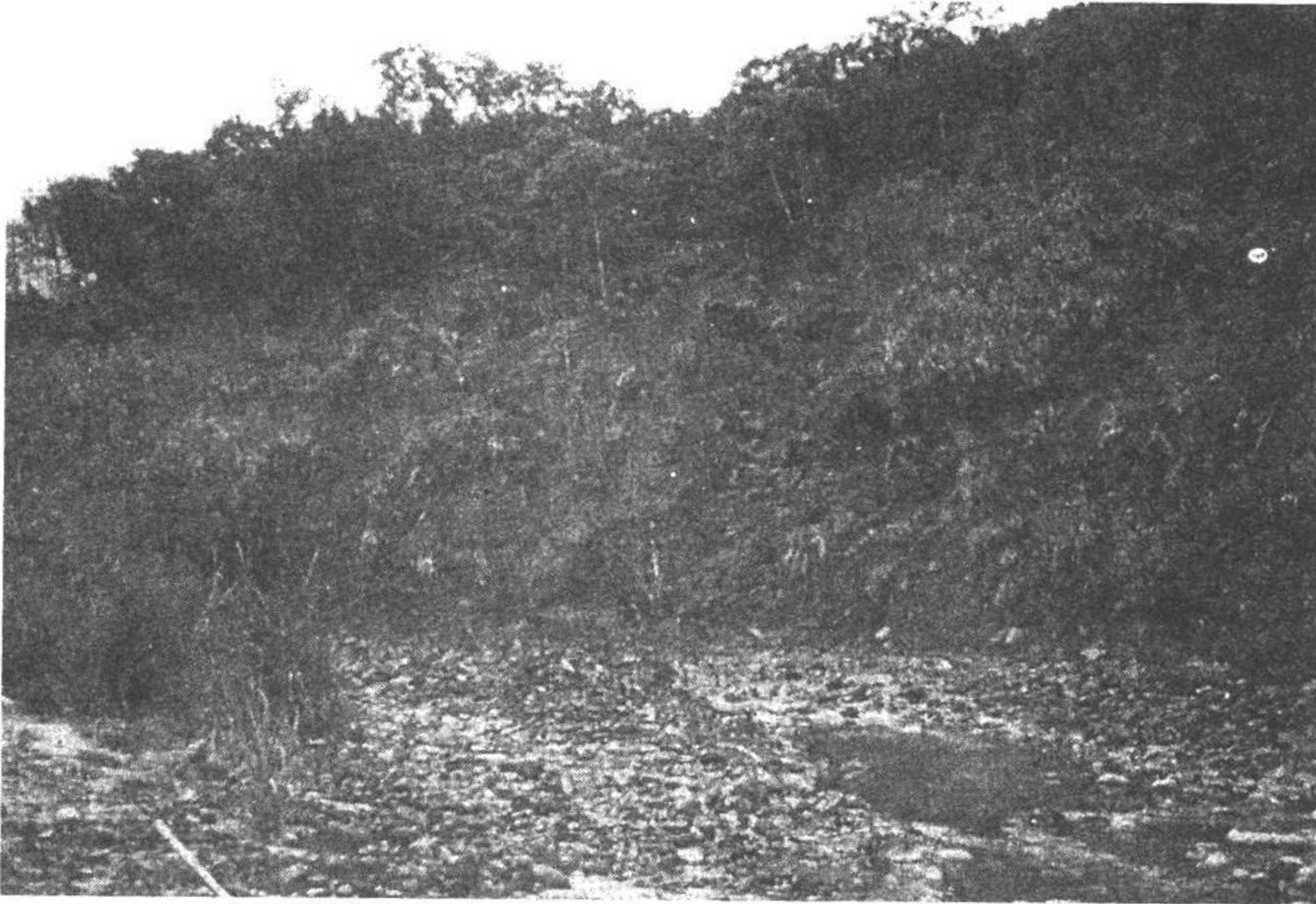
圖八 哆囉固溪邊坡 疏鬆，土壤易被沖 蝕
