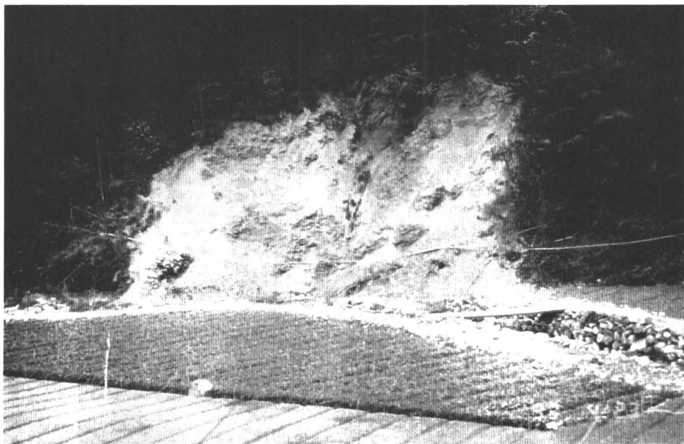
圖 11—2 有勝溪河床農墾地造成崩坍
